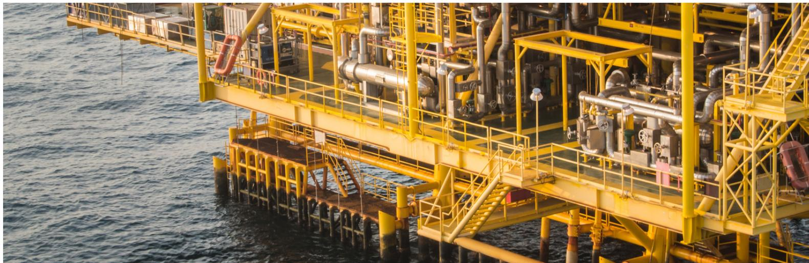
O sistema Maferpiso Mafergrade® MO para uso em "offshore" é um conjunto de grades soldadas por eletrofusão ou eletrodeposição destinadas ao uso por empresas exploradoras de petróleo e gás em plataformas marítimas.
